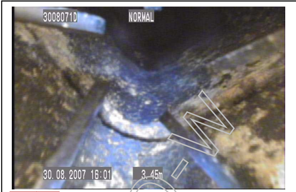
Nr. 2 Beschädigung Innenrohr: 3,45 m von dem oberen Reinigungsverschluss nach unten aus gesehen
