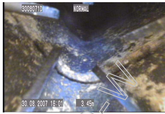
Nr. 2 Beschädigung Innenrohr: 3,45 m von dem oberen Reinigungsverschluss nach unten aus gesehen
